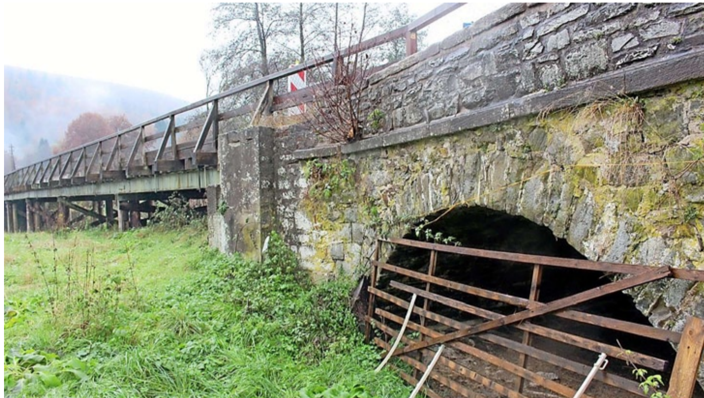
Eine Untersuchung brachte es an den Tag: An der Obermühlsbrücke, die erneuert werden soll, wohnt die Groppe.
